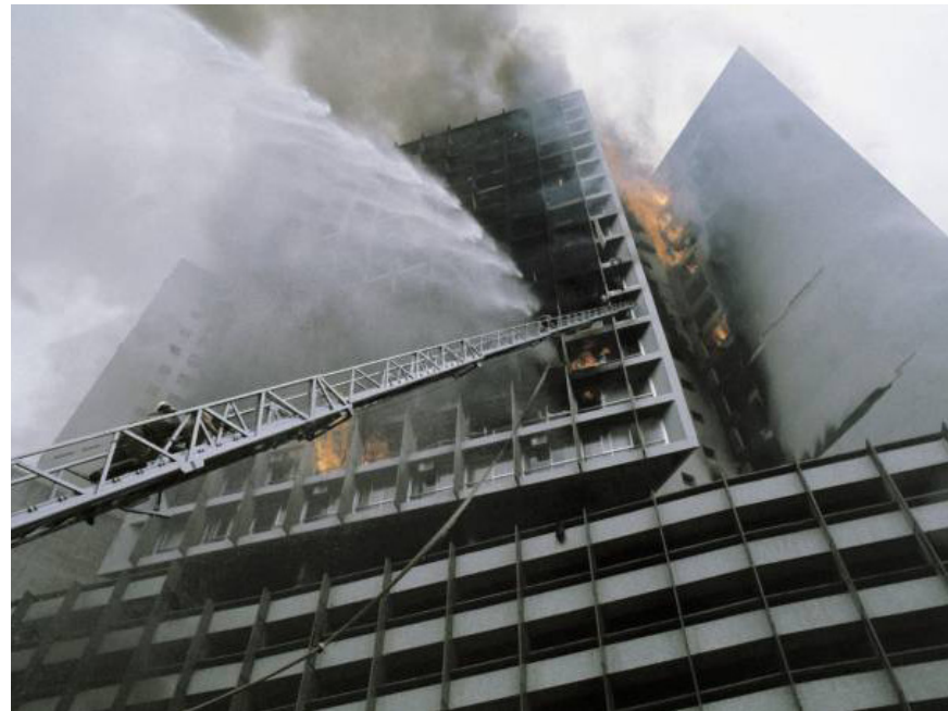
Edifício Joelma, incêndio em 1974
