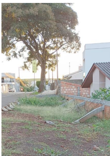
Figura 7 - Ausência de calçada - Rua Clevelândia, Bairro Fraron - Pato Branco - PR
