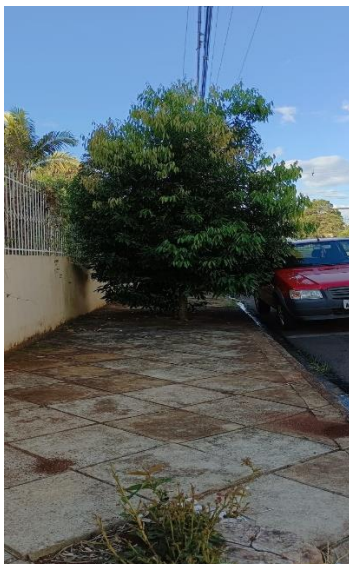
Figura 5 – Calçada com obstáculo que impede o tráfego das pessoas - Rua Luis Parzianello, Bairro Fraron - Pato Branco - PR
