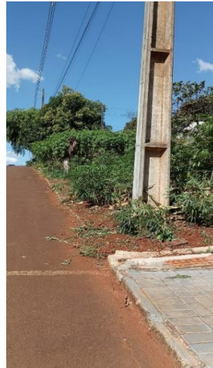
Figura 9 - Ausência e interferência no meio da calçada - Rua Martin Afonso de Souza, Bairro Fraron - Pato Branco - PR
