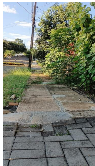
Figura 6- Calçadas sem manutenção - Rua Veríssimo Rizzi, Bairro Fraron - Pato Branco - PR
