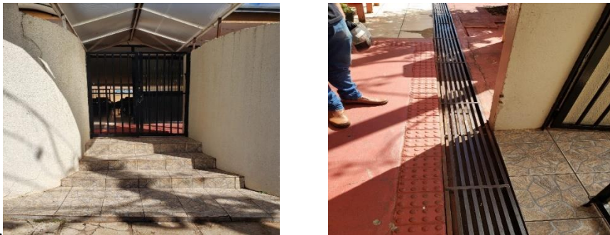
Figura 1- entrada no portão principal do colégio, com escadas; piso tátil junto a grelha do lado de dentro do pátio, na entrada do colégio Cristo Rei, Pato Branco, 2023.
